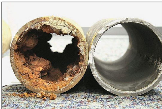
Figura 12: Zëvendësimi i gypave të asbest-çimentos
