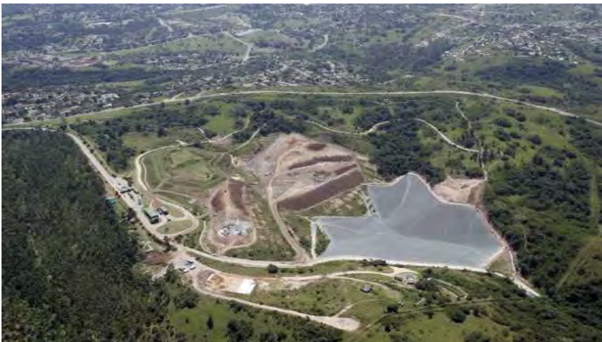
Figure 10. Deponi për Rigjenerimin e rrymës elektrike
